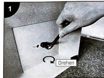
1. Nutzen Sie den Inbusschlüssel um die Stange an der Bodenplatte zu befestigen.
